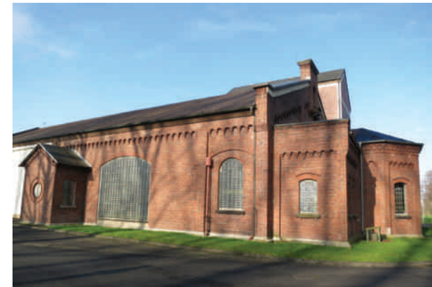
Abb. 48 Betriebsgebäude des Wasserwerkes (Qu.: Stadt Wetter (Ruhr))
