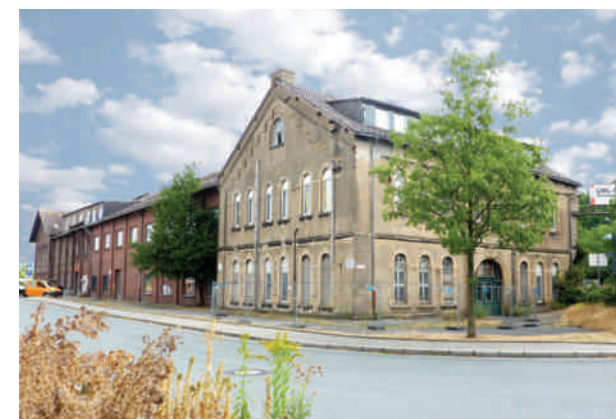
Abb. 34 Denkmalgeschützte Gebäude Werkstraße 40, Hattingen (Qu.: DTP)
