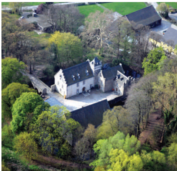
Abb. 60 Wasserschloss Werdringen (Qu.: Stadt Hagen)
