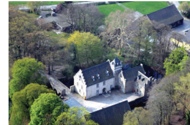
Abb. 54 Wasserschloss Werdringen (Qu.: Stadt Hagen)
